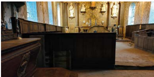
Stalles en cours de restauration et installation.
